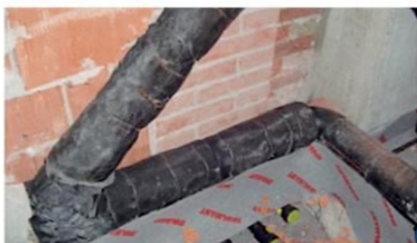
Fig. 25: particolare isolamento tubi
